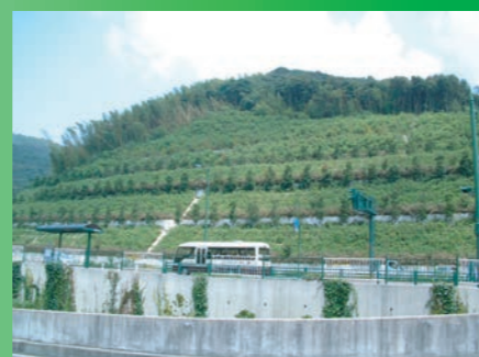
工事の1年5ヶ月後 (2003年8月)
