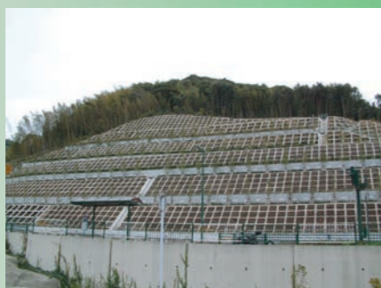
工事完成 (2002年3月)
